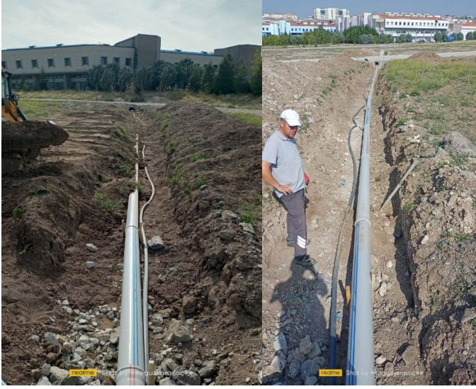
Şekil 2 Aranılan boru ve kablo hattının gömülmeden önceki görüntüleri
